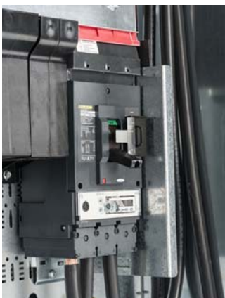
Powerpact L-Frame 250 A Main
